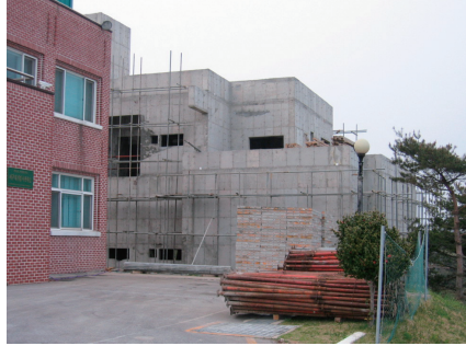
ㄴ, 연구동 증축 공사 장면 (2005년)
