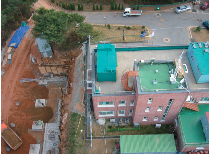
ㄴ, 연구동 증축 공사 장면 (2005년)
