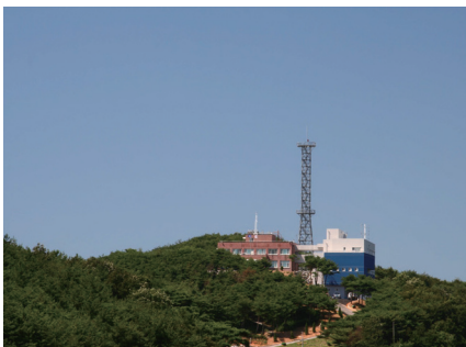
ㄴ, 지구대기감시관측소 전경(2005)
